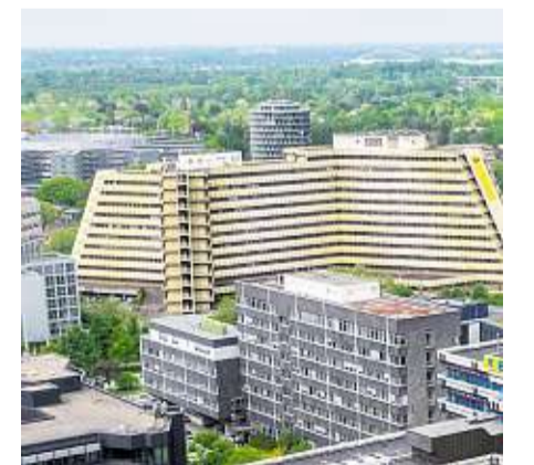
Die frühere Oberpostdirektion soll 2017 abgerissen werden TA CAPS/Thorsten Ahlf
